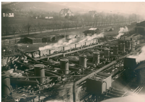
Widok na pracującą rafinerię (w tle wille dyrektorskie przy obecnej ul. Willowej), 1909-1914 r., ze zbiorów Archiwum Narodowego w Krakowie.
