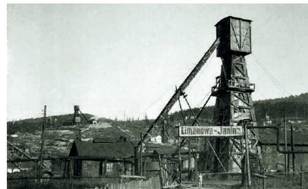
Wieża wiertnicza w Borysławiu z szybem naftowym Limanowa - Janina, przed 1914 r., ze zbiorów do albumu „Okruchy Pamięci. Limanowa na starej fotografii”.
